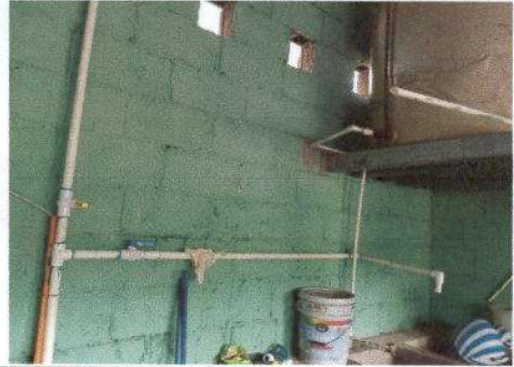
FOTO 2: Sustrucción de tubería línea principal
