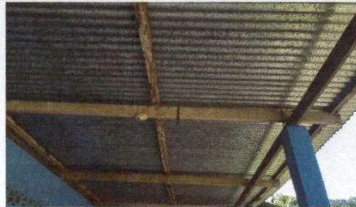
FOTO 7: Sustrucción de estructura de soporte de madera, por metal (AULA)
