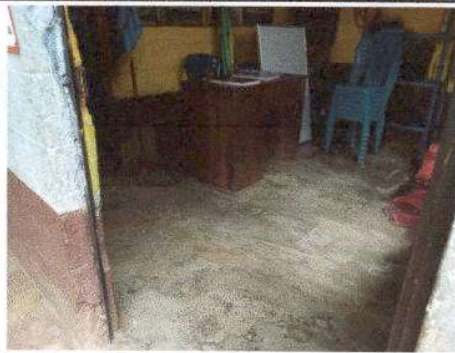
FOTO 6: Sustrucción de piso cerámico (AULA)
