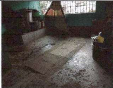
FOTO 9: Reparación de piso de torta de concreto (COCINA)
