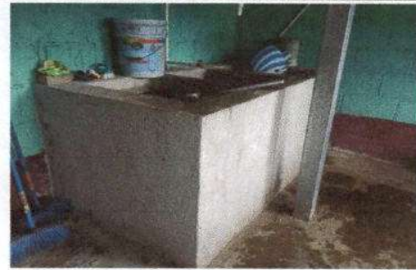
FOTO 10: Sustrucción de Azulejo de Pila (COCINA)
