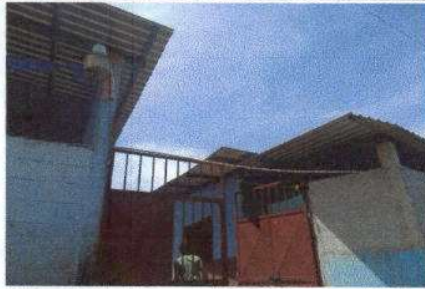
FOTO 11: Sustrucción de canal de metal (PATIO)
