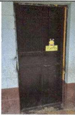
FOTO 3: Mantenimiento a estructura (lijado, cambio de tubo, cepillado, sujeciones, aplicación de pintura) (AULA)
